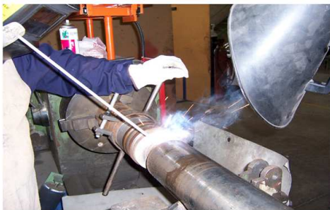
Soldaduras en barras de inyección
