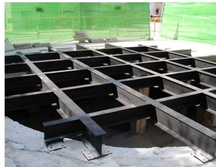
Structure métallique IPN
